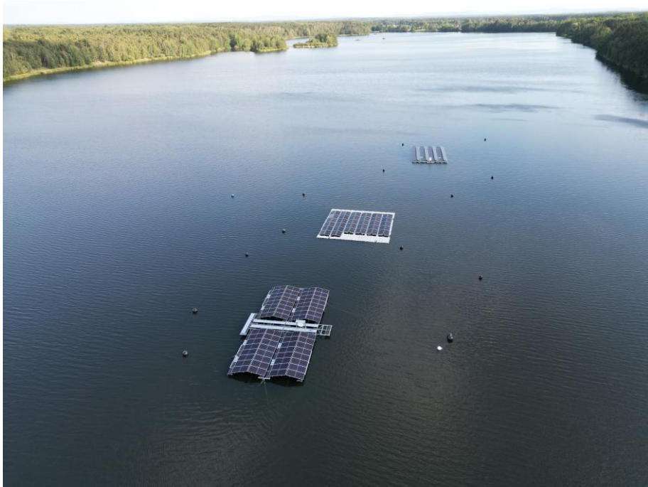
3 schwimmende Anlagen in der Lausitz
