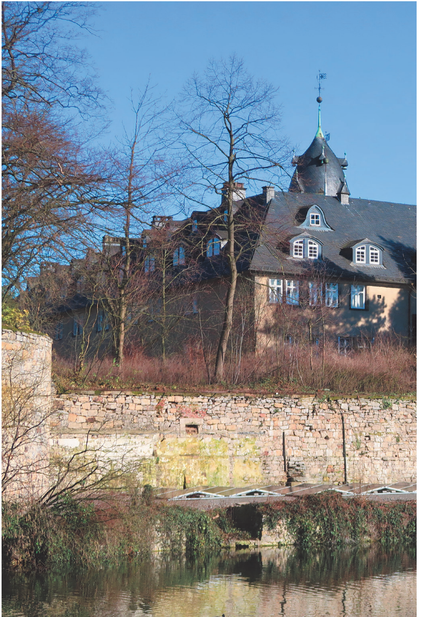
Großflächige PV-Anlage im Außenbereich einer Schlossanlage
