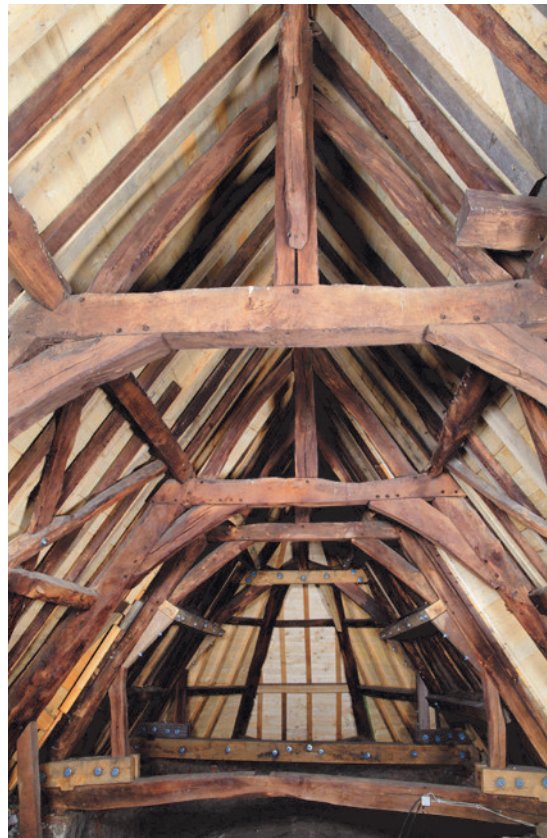
47.-48. Bauzeitliche Dachkonstruktionen dürfen durch Lasterhöhungen beim Aufbringen einer Solaranlage nicht beeinträchtigt werden.
