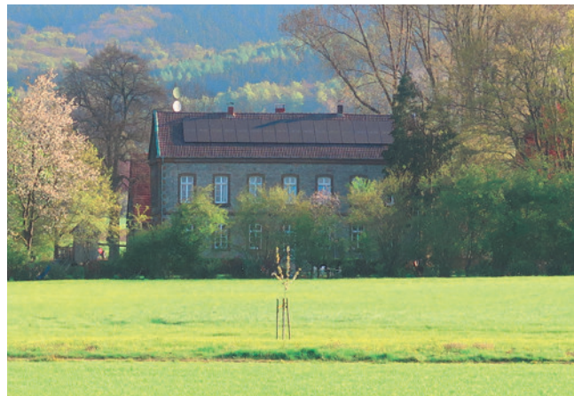
65. Farblich an die Dachfläche angelehnte dunkle PV-Module
