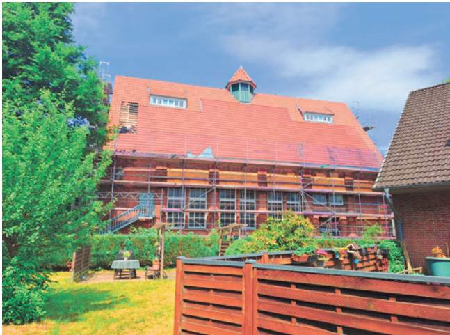
71. Ersatz von Anteilen einer bestehenden Oberfläche durch kleinteilige, der Eindeckung ähnliche Module
