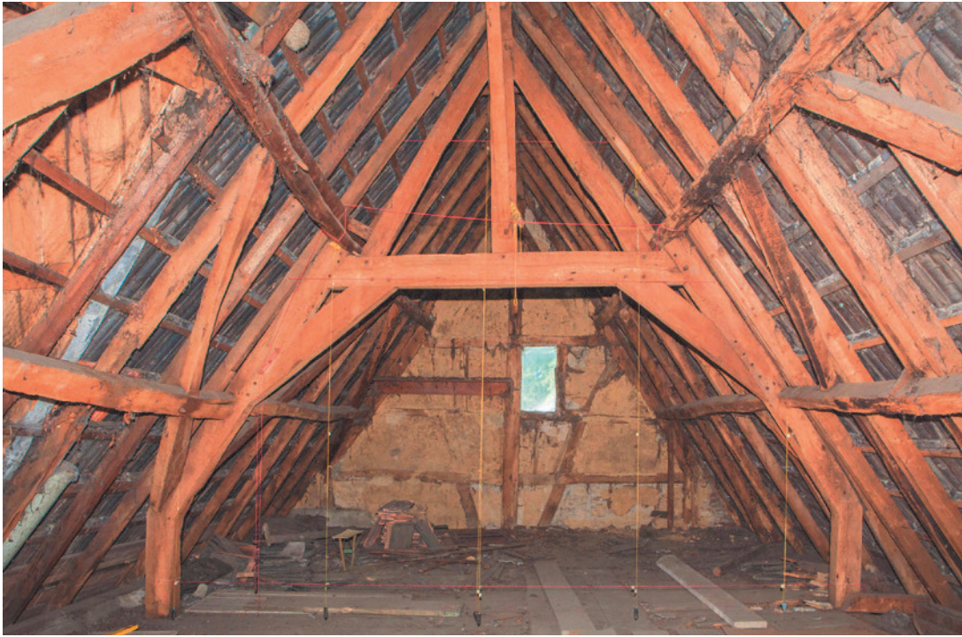
47.-48. Bauzeitliche Dachkonstruktionen dürfen durch Lasterhöhungen beim Aufbringen einer Solaranlage nicht beeinträchtigt werden.
