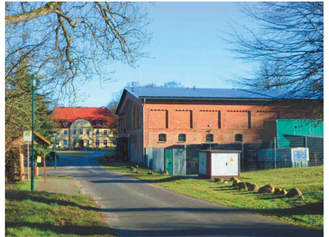
72. Vollständiger Ersatz der Dachoberfläche
