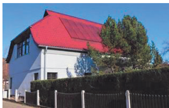
66. Farblich an die Dachfläche angepasste rote PV-Module
