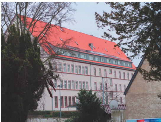
63. auf einer Schleppgaube auf der Gebäuderückseite
